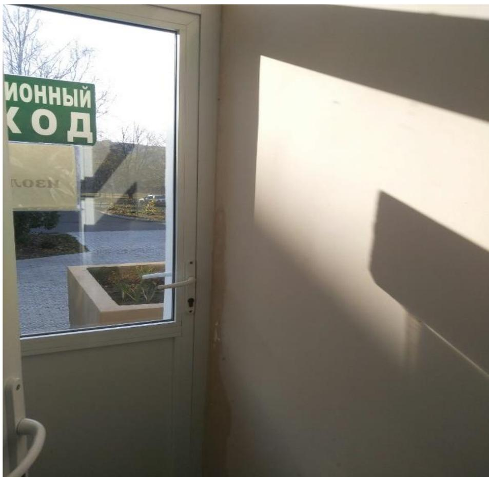
Рисунок 1. Следы влаги у входных дверей
