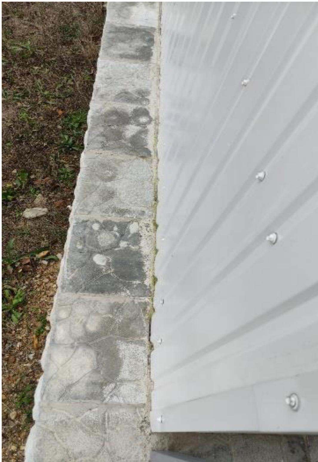
Рисунок 2. Щель между фундаментом и стеной ФАПа
