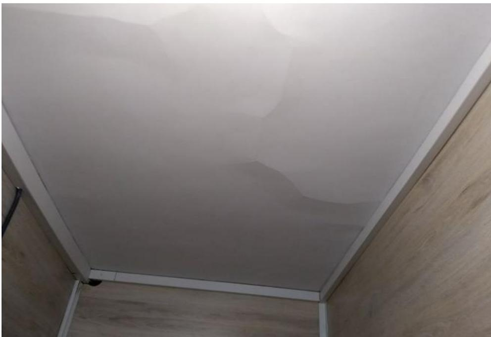
Рисунок 1. Потолок ФАПа покрыт трещинами
