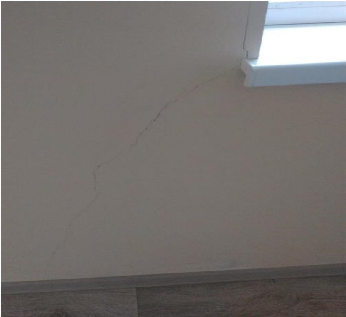
Рисунок 2. Трещины на внутренней отделке
