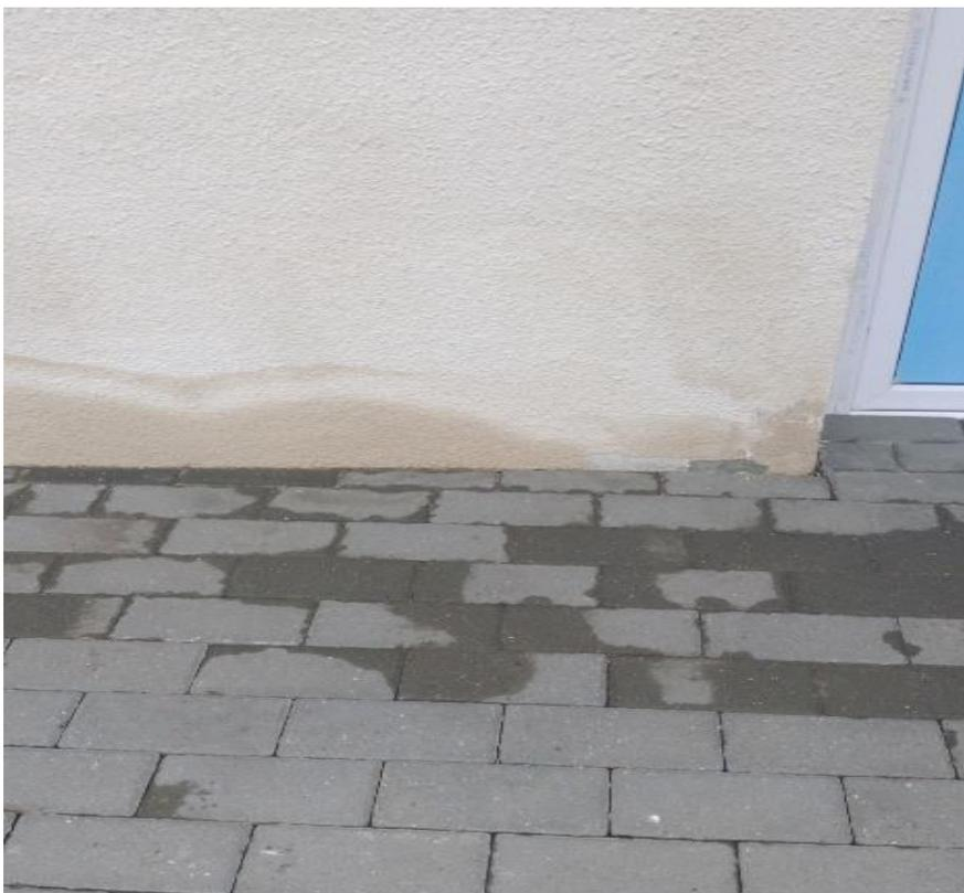
Рисунок 1. Следы сырости на стенах ФАПа
