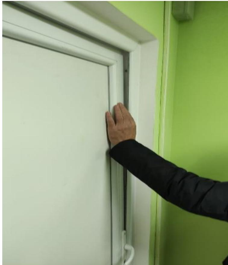
Рисунок 5. Входная дверь имеет щели и болтается
