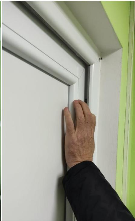
Рис.2. Входная дверь «болтается»
