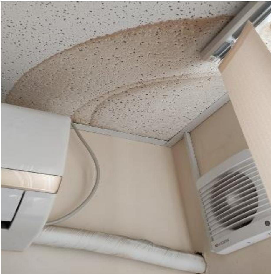
**Рис.2. Следы протечки на потолке**
