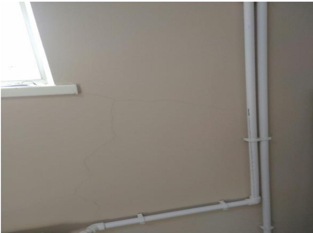
Рис.2. Микротрещины на стенах
