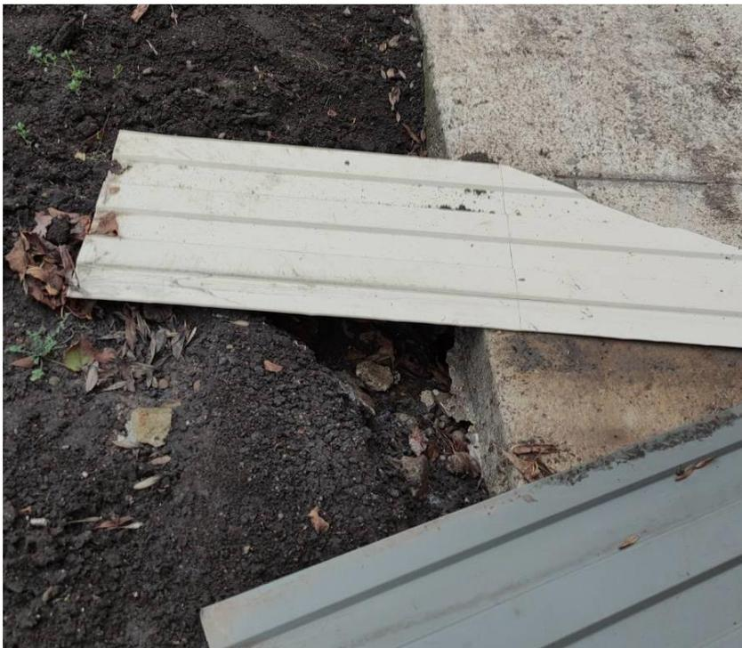
Рис.2. Влага затекает под «отмостку» в подвал
