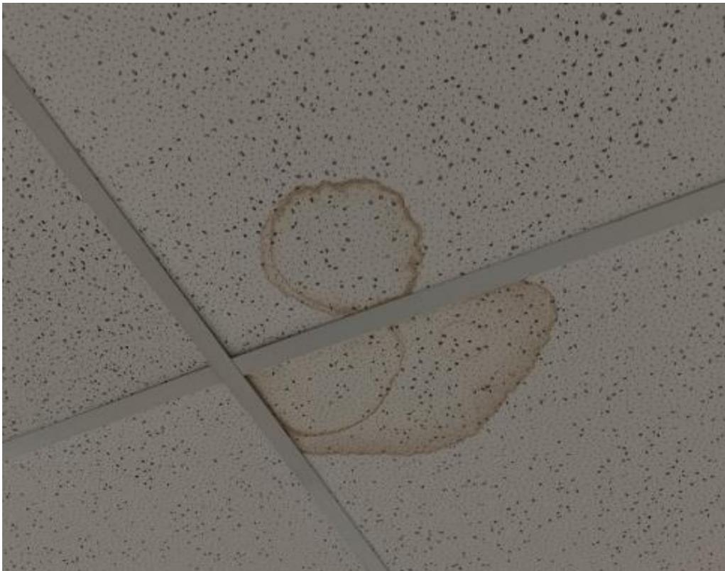
Рисунок 1. Следы протекания кровли
