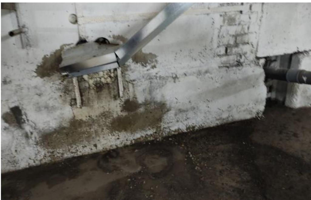
**Рис.1. Влага попадает на короб с электропроводкой !!!!!**
