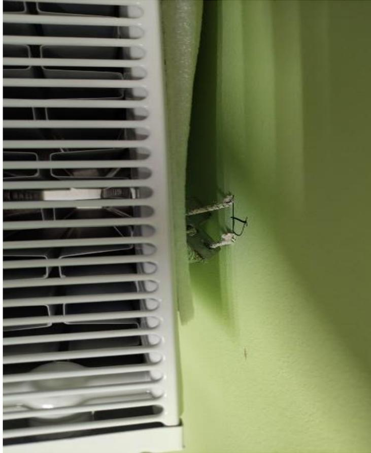
Рисунок 4. Радиатор «вырван» из стены
